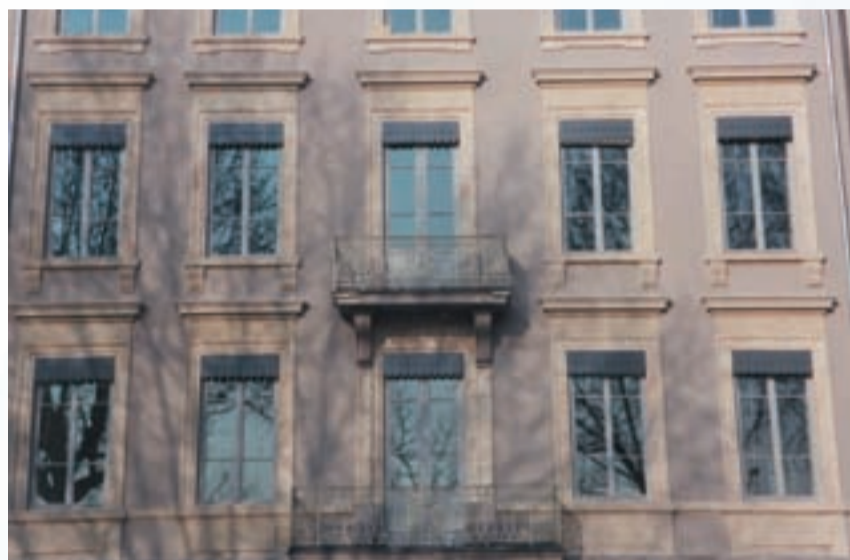
Restauration du 3, quai Jean Moulin à Lyon
