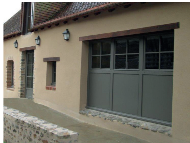
GRAND CHÂSSIS 1 VANTAIL AVEC LIMITEUR D'OUVERTURE HAUT ET BAS ET PORTE OUVERTURE EXTÉRIEUR LASURÉE
